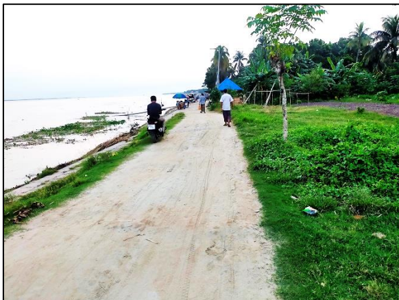
Road-16, Naria Pourashava
