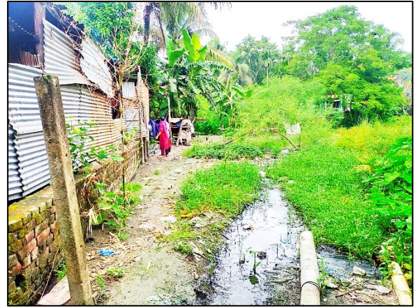
Drain- 9, Naria Pourashava
