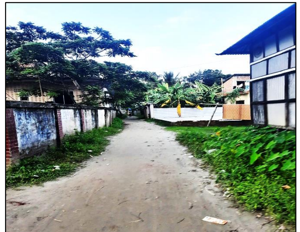
Drain -30, Naria Pourashava
