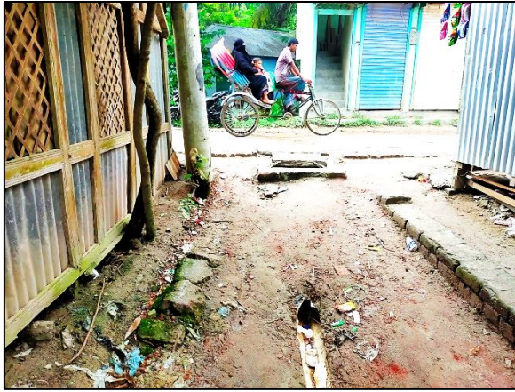
Drain -9, Naria Pourashava
