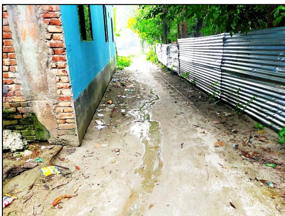
Road-35, Naria Pourashava
